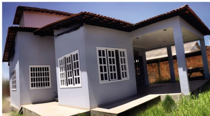
FASE DE EXECUÇÃO
