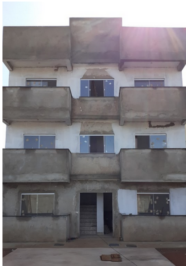
Condomínio, Valparaíso de Goiás-GO, 2020 Acompanhamento e Fiscalização (Construção)
