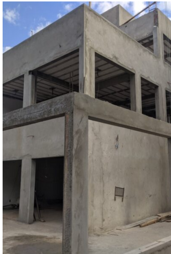
Edifício Comercial, Brasília-DF, 2023 Acompanhamento e Fiscalização (Construção)
