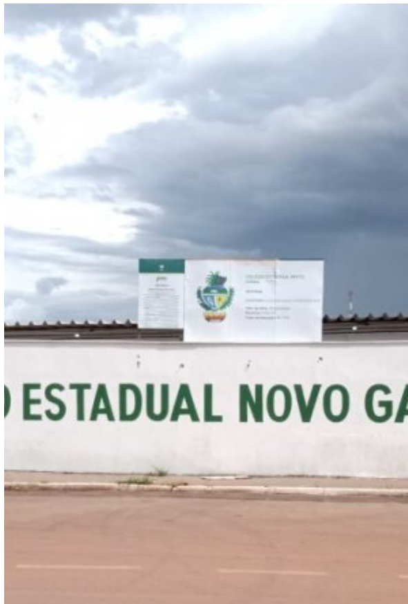
Colégio, Novo Gama-GO, 2023 Acompanhamento e Fiscalização (Civil e Elétrica)
