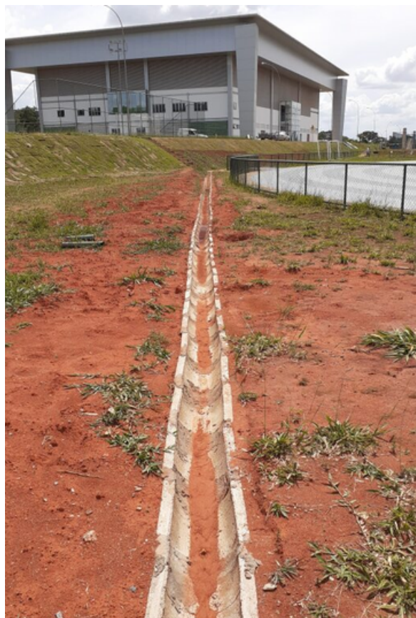
CMP Exército, Brasília-DF, 2020 Acompanhamento e Fiscalização (Construção)
