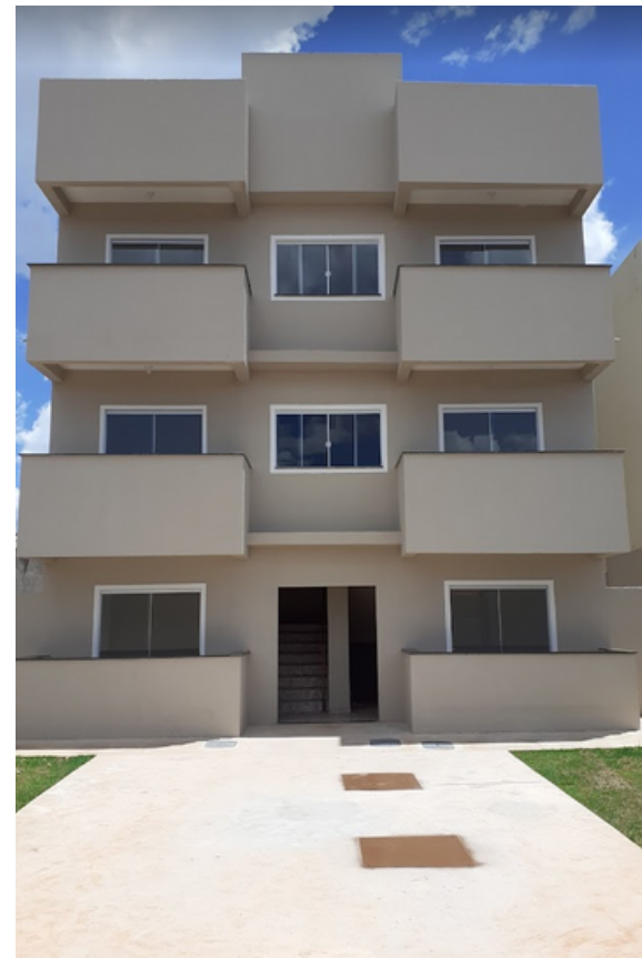
Condomínio, Valparaíso de Goiás-GO, 2020 Acompanhamento e Fiscalização (Construção)
