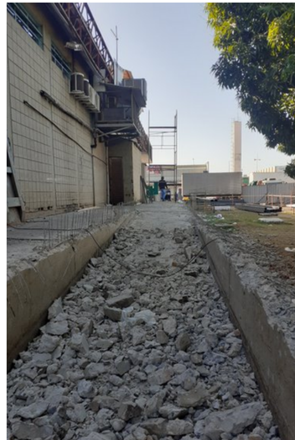
Ceasa, Brasília-DF, 2022 Execução (Civil)
