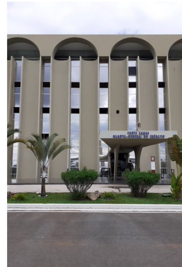
Quartel General do Exército, Brasília-DF, 2021 Acompanhamento e Fiscalização (Civil)
