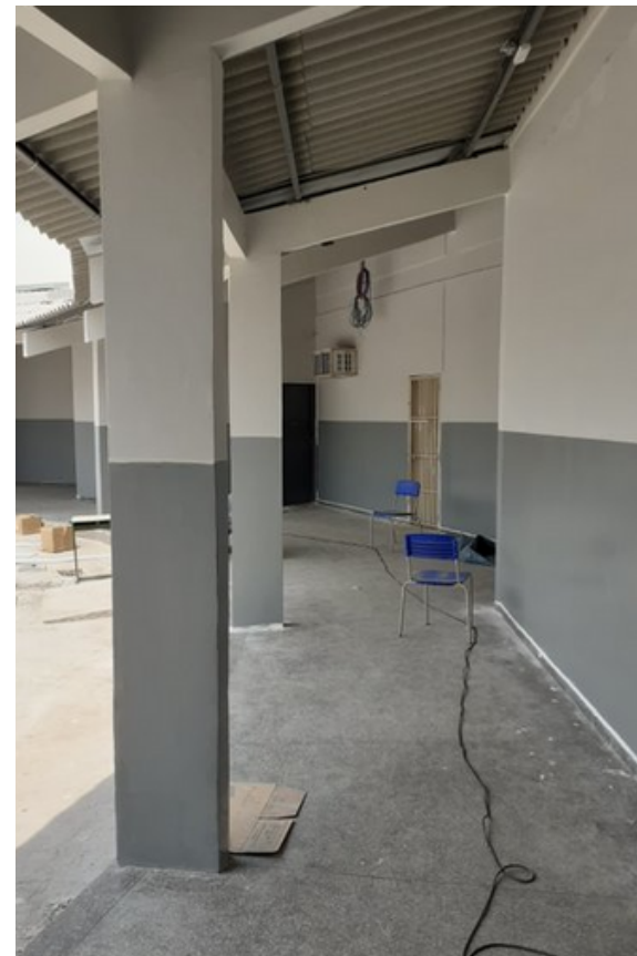
Colégio, Valparaíso de Goiás-GO, 2021 Acompanhamento e Fiscalização (Civil e Elétrica)
