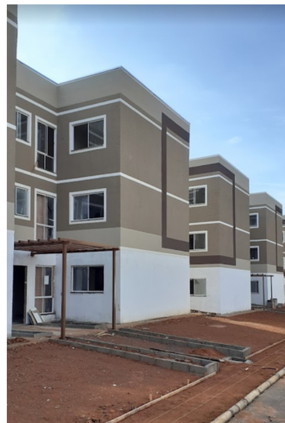
Condomínio, Valparaíso de Goiás-GO, 2021 Acompanhamento e Fiscalização (Civil)
