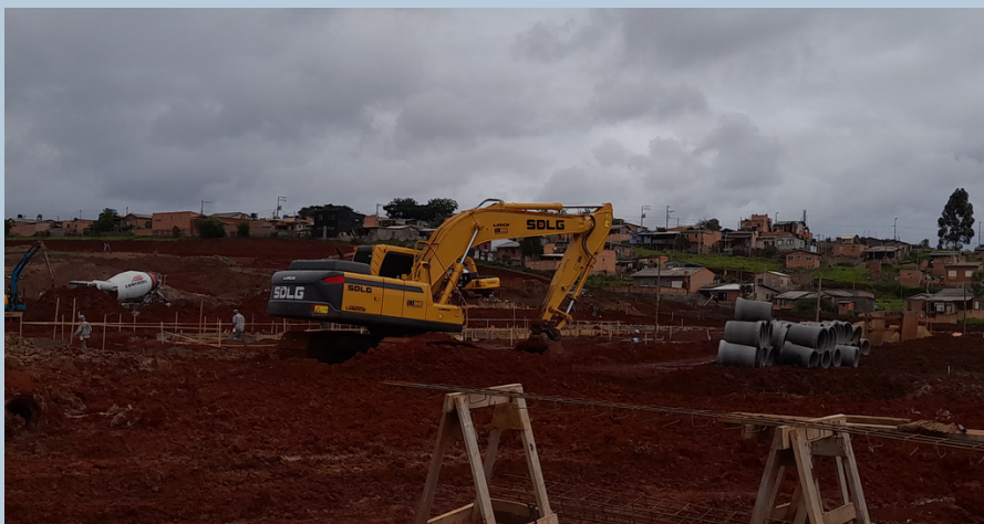
Acompanhamento FullTime INSPEÇÃO DE MÁQUINAS E EQUIPAMENTOS INSPEÇÃO DE USO DE EPIS
