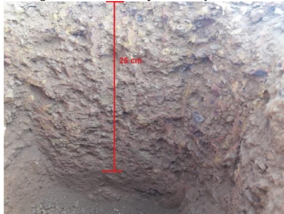
Figura 6. Camadas de pavimentação in loco.
