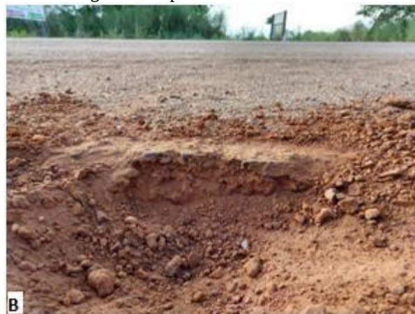
Figura10. Espessura do revestimento.
