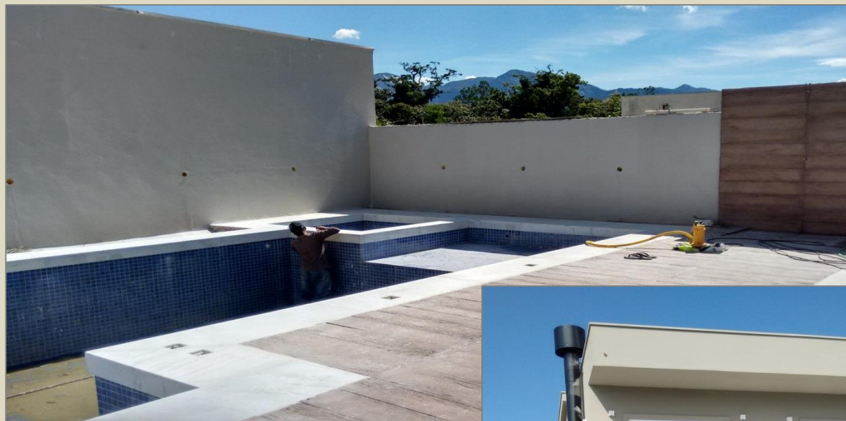
Área de lazer - Fotos tiradas durante as visitas à obra.
