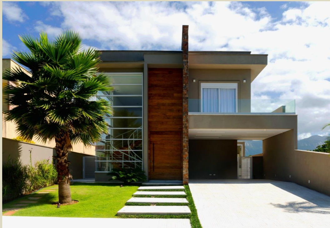
Foto da residência concluída – Fachada Frontal
